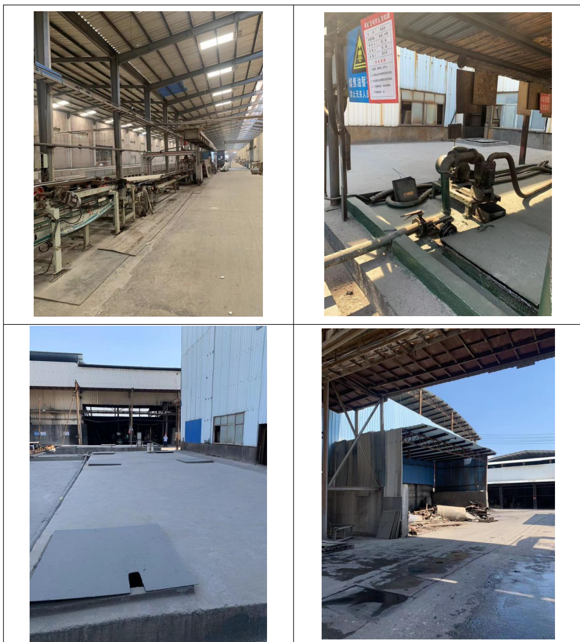
图 7.1-1 厂区内地面硬化照片
