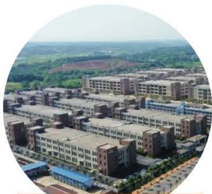
现代工业风貌区
